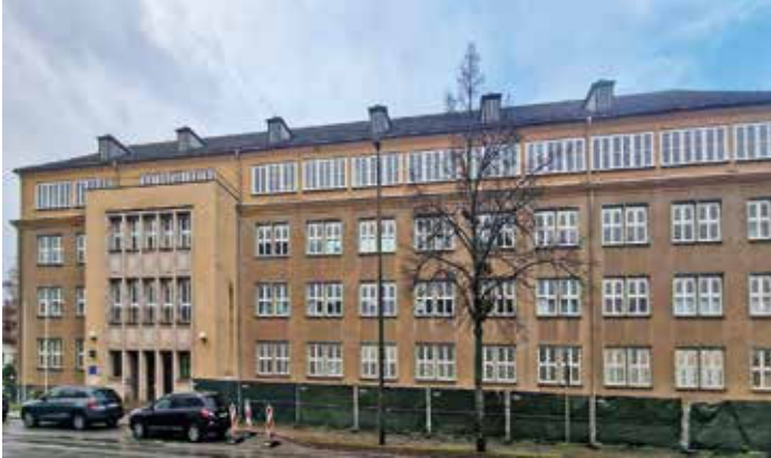
Das Hauptgebäude wird saniert.
