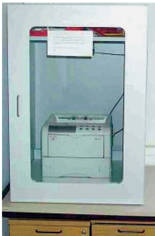
Laserdrucker im luftdichten Spezialschrank mit Außenabluft an einer Polizeidienststelle
