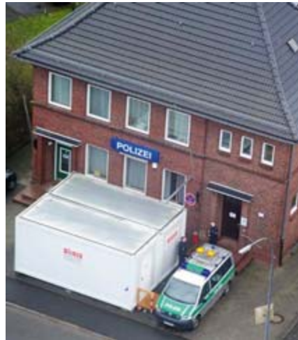
Das Bild zeigt das Quickborner Dienstgebäude unmittelbar nach der Räumung wegen Schimmelpilzbefalls.
